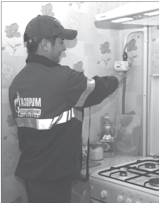
Проверка оборудования сотрудниками газовой службы поможет избежать беды.
